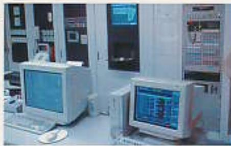
総合防災センターとは、当院の全ての防災設備を管理し、例えば院内の火災報知器が感知しますと、どこかの場所が火災が起きたかモニターが場所を表示、同時に火災報知器が作動したことを自動的に放送するシステムになっており、一方24時間体制で監視している職員が現場に急行し事実確認をし、患者様方にお知らせする流れになっております。もし災害が起こった時に当院の職員の協力、連携が上手く行かないと2次、3次災害が発生致しますので発生を防止する為に職員全員を対象とし十一月に総合防災訓練、(火災時訓練、地震時訓練、通報訓練)、消火器、屋内消火栓の取扱い訓練を行い、二月に部分マニュアル訓練を実施していま
